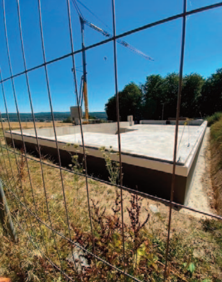
Die Bodenplatte der neuen Hochbehälterhalle
