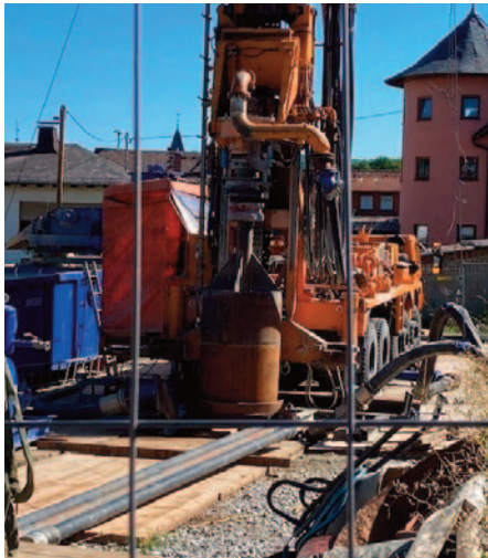
Mit der oben gezeigten Bohrmaschine wird so tief gebohrt bis man an die wasserführende Schicht gelangt. Foto: Titus Mertens
