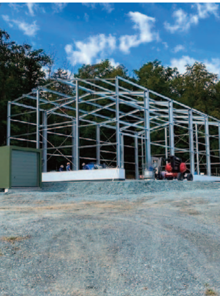
Das Grundgerüst der Hochbehälterhalle
