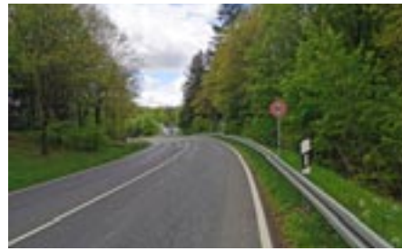
B275 Riedelbach Richtung Reichenbach: Hier fehlt das Fußgängerschild und das Tempo sollte auf 60 km/h reduziert werden
